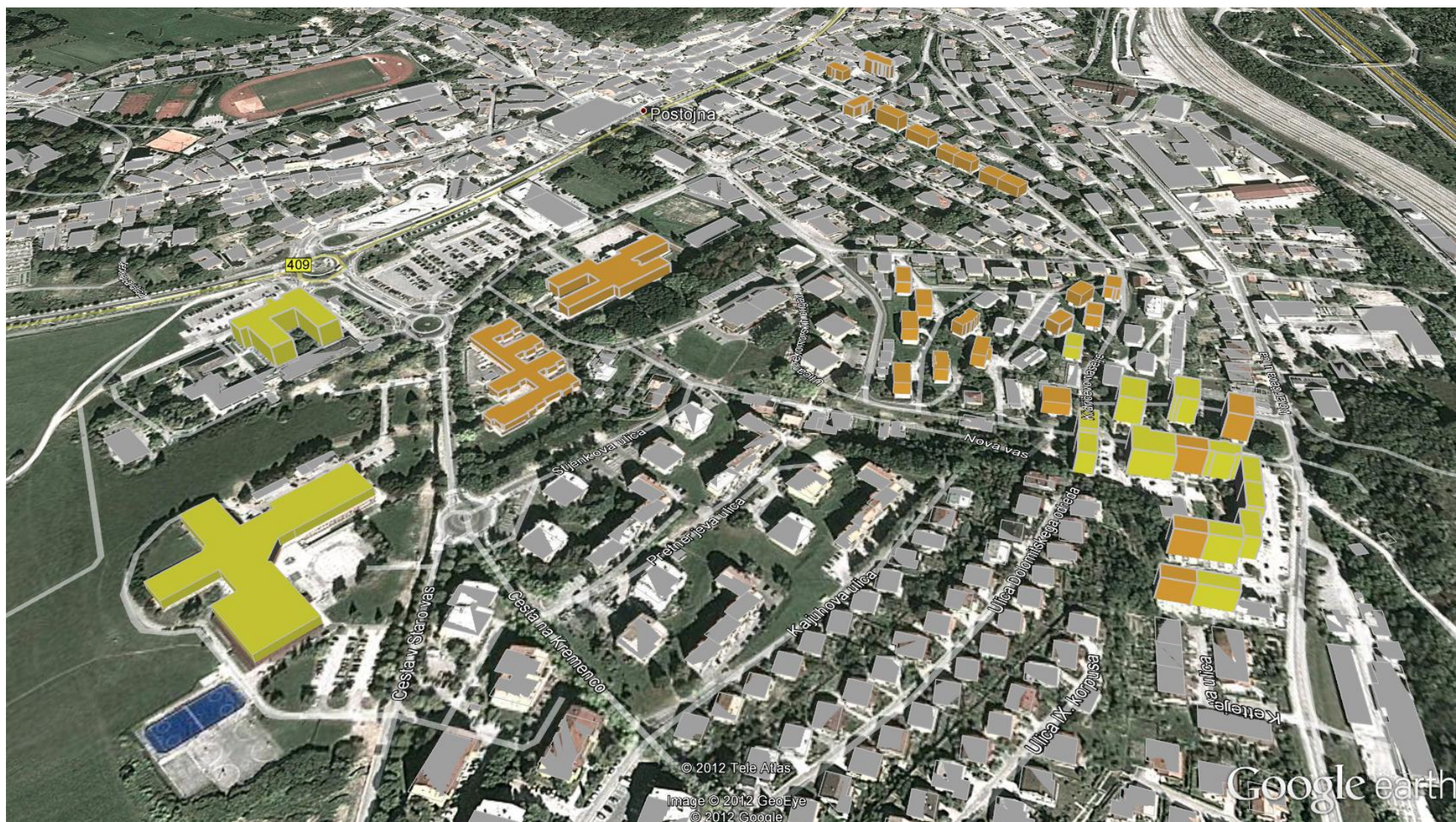
Slika 33: Stavbe v mestu Postojna, ki so priključene na daljinsko ogrevanje na lesno biomaso – DOLB.
